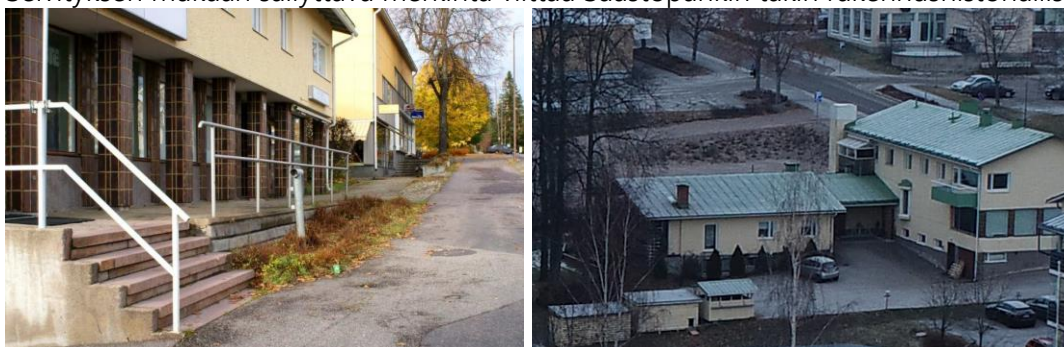
Kuva Vasemmalla Säästöpankin talon julkisivun klinkkeripintaa (Kuva: Teija Ahola). Oikealla viistokuvista (MMPalvelu Puttonen 2022) tallennettu leike takajulkisivusta.
